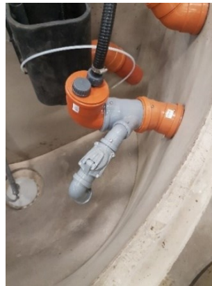
Bild 2 (insida brunn vid självfall)
