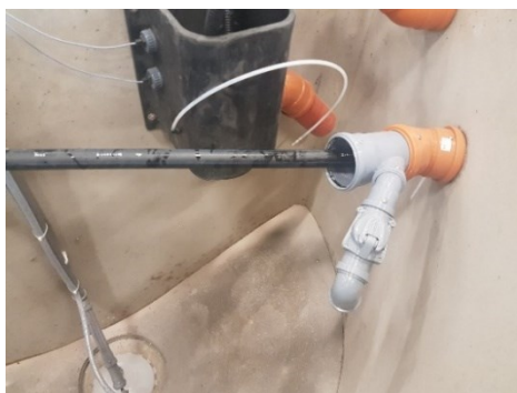
Bild 3 (insida brunn vid pumpning med bräddavlopp) Slanginstick ca 1 m
