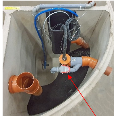
Bild 2 (insida brunn vid självfall)
