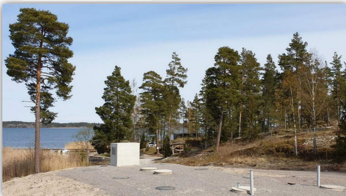
Figur 2 - WSB Clean 100 PE SO +P med installerad UV-modul vid Kouden i Söderköpings kommun
