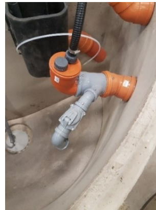
Bild 2 (insida brunn vid självfall)
