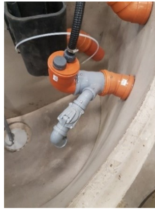
Bild 2 (inside brunn vid självfall)
