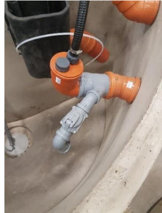
Bild 2 (insida brunn vid självfall)
