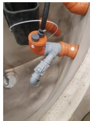
Bild 2 (insida brunn vid självfall)
