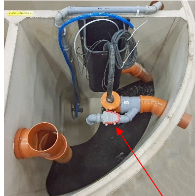
Bild 2 (insida brunn vid självfall)
