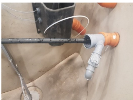
Bild 3 (insida brunn vid pumpning med bräddavlopp) Slanginstick ca 1 m
