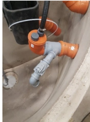
Bild 2 (insida brunn vid självfall)
