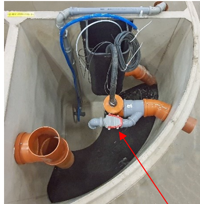
Bild 2 (insida brunn vid självfall)
