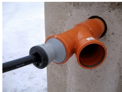
Bild 4 (utsida brunn vid pumpning med bräddavlopp). Grenrör används för bräddavlopp.
